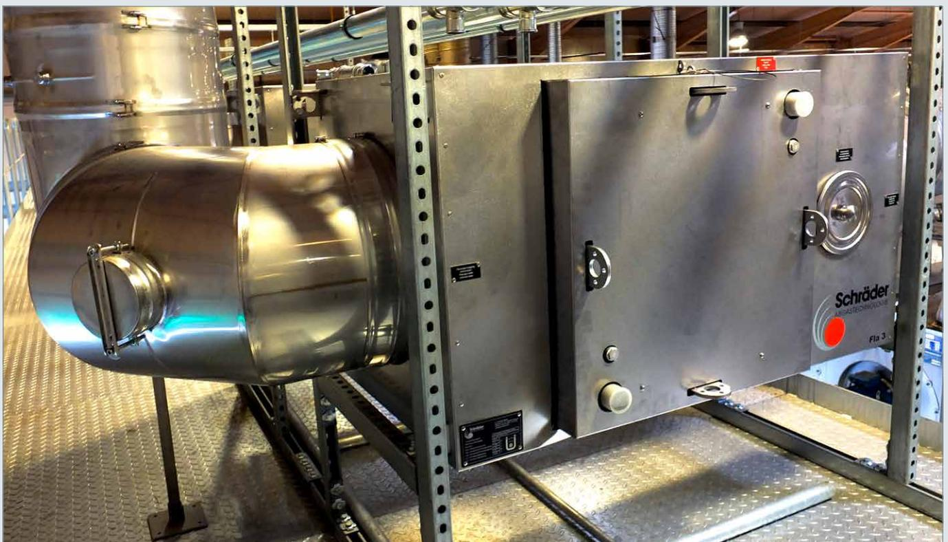
Wärmetauscher mit primärseitiger Zuführung der Abwärme
