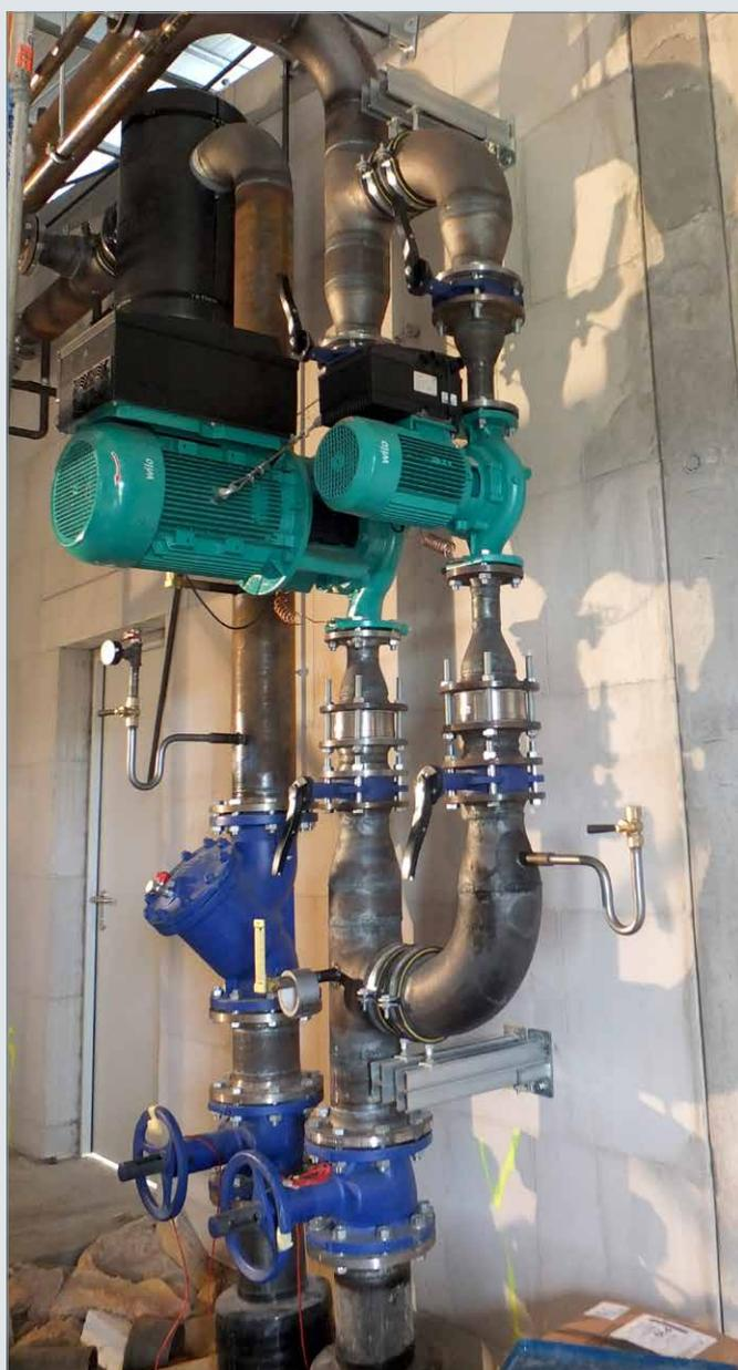
*Doppelpumpen zur Förderung der Wärmeenergie in das Nahwärmenetz*
